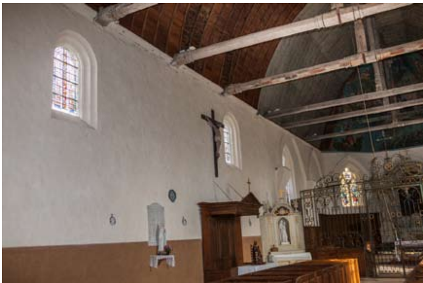
Façade nord, avec des baies romanes
